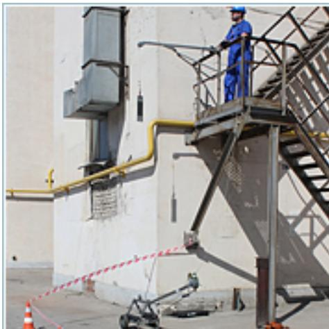
Эксплуатационные испытания наружных пожарных лестниц и ограждений кровли здания проводятся согласно [ГОСТ Р 53254-2009](#). Указанный документ определяет общие технические требования, предъявляемые к пожарным лестницам и ограждениям кровли:
